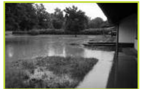
Das Wasser dringt bis in die Freihalle von Haus 1
